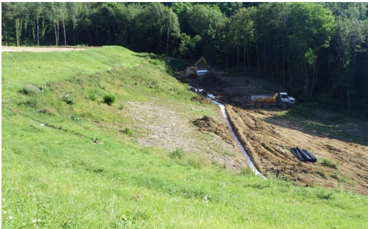
Figures 13. Réalisation de la tranchée drainante en pied de digue et creusement de l'éperon de drainage avec géotextile qui emballle le drain en pied
